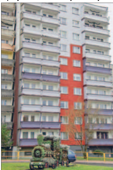
Osiedle „Młodych”. Wyremontowano balkony przy Niepodległości 30
