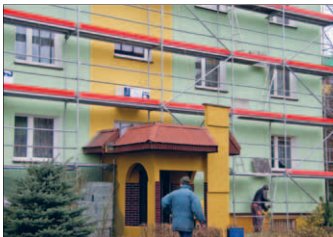
Osiedle „Bańgów”. Jeśli tylko warunki na to pozwalają, przy Skłodowskiej-Curie 25-33 robotnicy ocieplają elewacje
