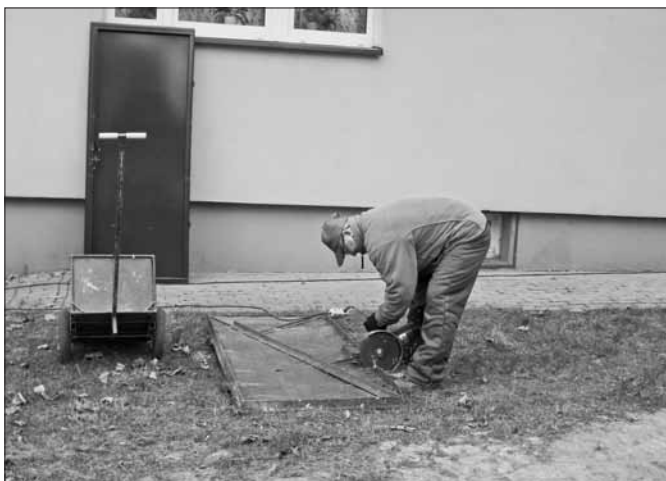
„Tuwima”. Stare... na nowe drzwi zewnętrzne do zsyppów
