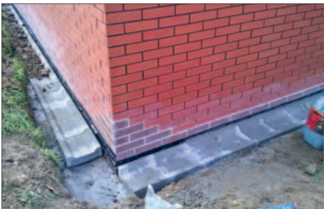
Osiedle „Węzłowiec”. Po realizacji przez Urząd Miasta nowego parkingu konieczne stało się wykonanie odwodnienia ścian garaży przy Grunwaldzkiej 16C
