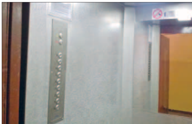
Osiedle „Węzłowiec”. Władysława Jagiełły 3D wykonano kapitalny remont kabiny dźwigu osobowego
