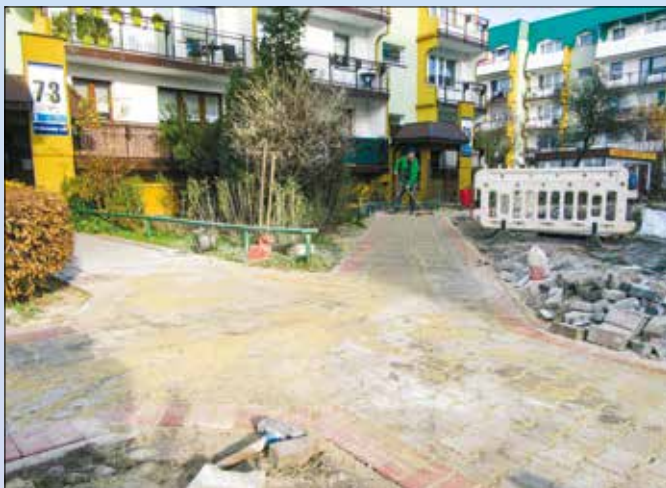
os. „Bańgów”. Wymiana chodników będzie jednym z priorytetów najbliższych lat – tu: wykonany już przy M. Skłodowskiej-Curie 69-37A
