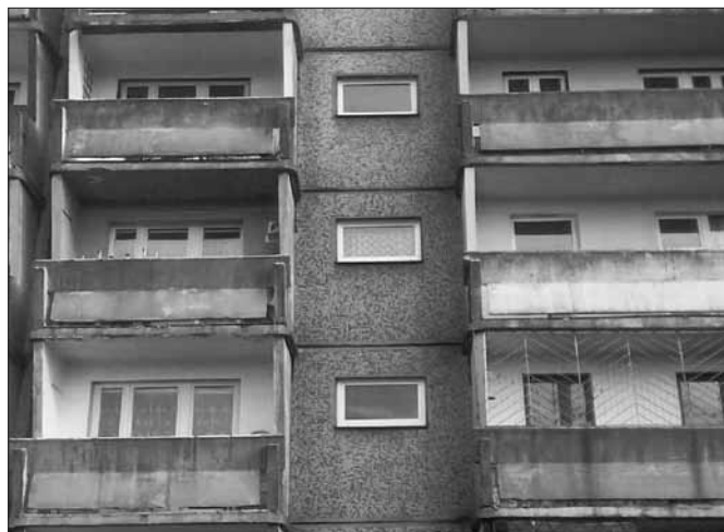
Osiedle „Węzłowiec”. Władysława Jagiełły 39A, B – wymieniono okna w klatkach schodowych
