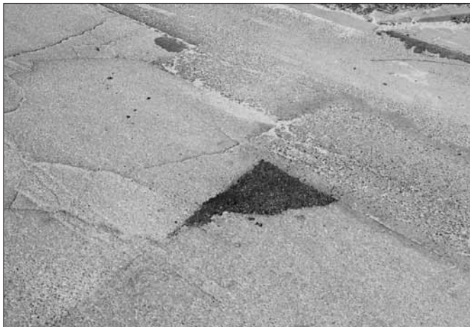
W „Bańgowie” wszystkie ubytki w drogach osiedlowych spółdzielczych są już uzupełnione
