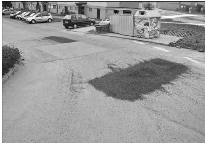
W marcu część zadań, jakie zleciły administracje dotyczyły uzupełnienia ubytków w drogach
