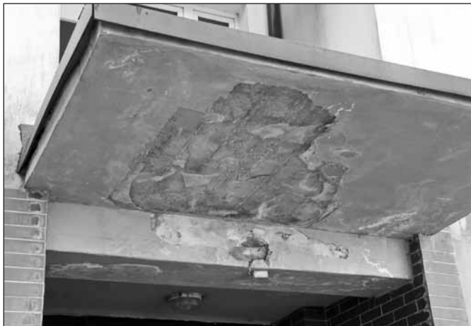
Tej zimy daszek nad wejściem do klatki przy R. Gansińca nie oparł się wpływowi niskich temperatur i wody
