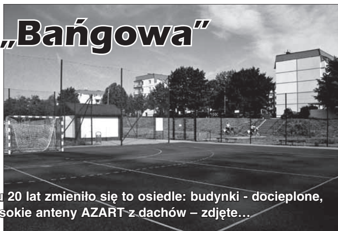
Widać wyraźnie, choćby z tej perspektywy, jak w ciągu 20 lat zmieniło się to osiedle: budynki - docieplone, boisko – nowe, drzewostan – dorodny, wysokie anteny AZART z dachów – zdjęte...
