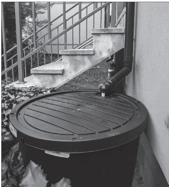
Zbieranie „deszczówki” na potrzeby np. pielęgnacji kwiatów w mieszkaniu i w przydomowym ogródku.
