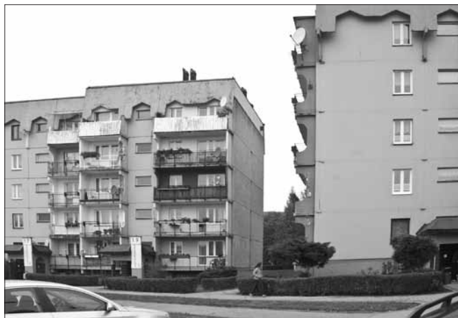
os. „Bańgów”. W przyszłym roku to budynki przy M. Skłodowskiej Curie 17-19 i 21-23 będą w rusztowaniach
