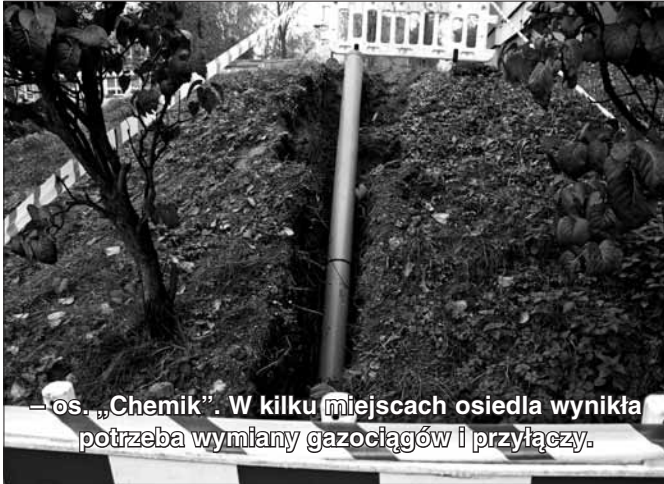
– os. „Chemik”. Wymiana rur gazowych wiąże się niestety ze zniszczonymi na jakiś czas trawnikami
