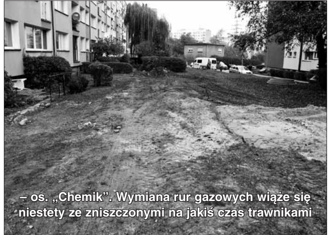
– os. „Chemik”. W kilku miejscach osiedla wynika potrzeba wymiany gazociągów i przyłączy.
