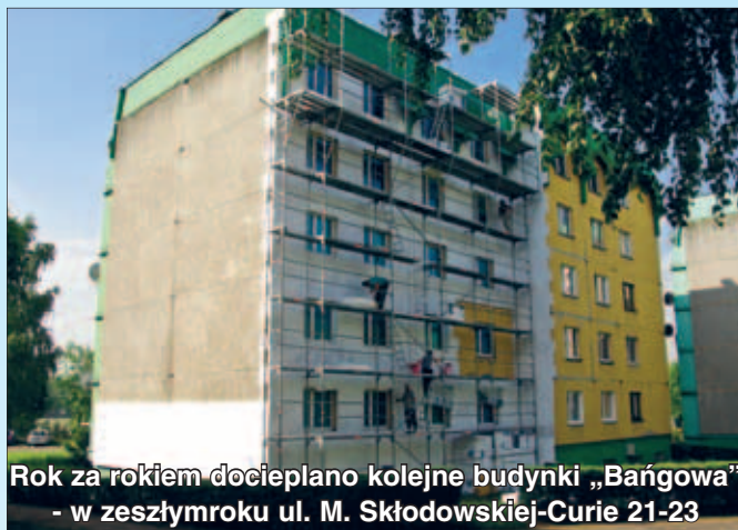
Coraz mniej budynków zostało do docieplenia. W tym roku znikną w „Bańgowie” potocznie nazywane „czerwone bloki”
