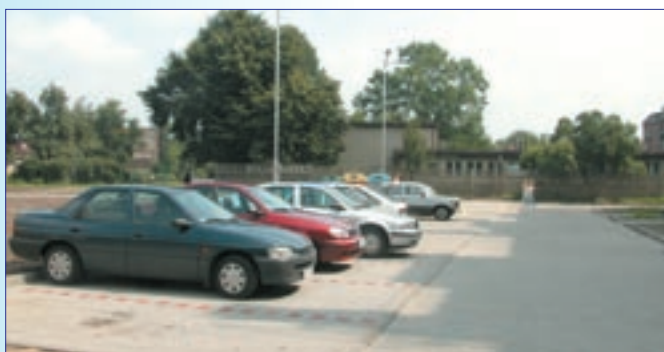
Powstało dziesiątki nowych miejsc parkingowych, docieplono 28 budynków.
