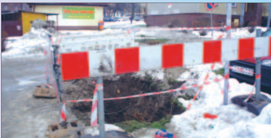
Wymiana wodociągu przy budynkach Władysława Jagiełły 1, 2 i 3 – os. „Węzłowiec”
