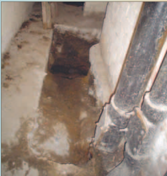
Remont instalacji deszczowej w budynku przy ul. Okrężnej 1 – os. „Tuwima”
