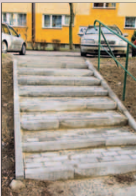
Osiedle „Chemik” – wykonane nowe schody zewnętrzne w rejonie budynku przy ul. Walerego Wróblewskiego 57.
