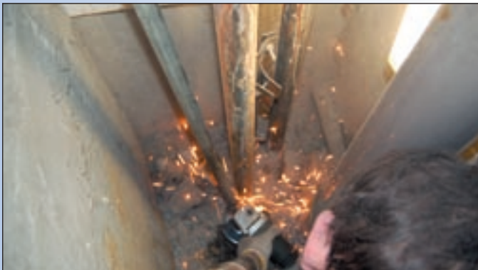
Wycinanie starych pionów w ciasnym szachcie to problem. Dobrze, gdy mieszkaniiec obudowując kanał techniczny, zostawił odpowiedniej wielkości otwór rewizyjny.
