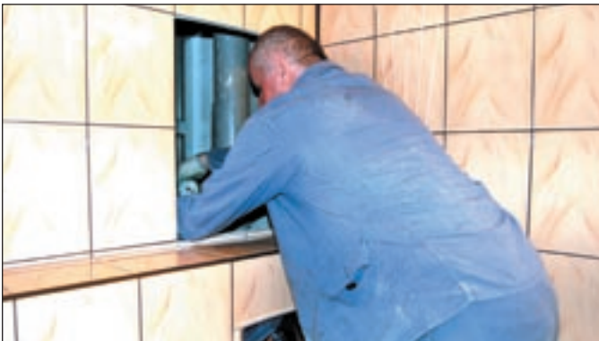
Wycinanie starych pionów w ciasnym szachcie to problem. Dobrze, gdy mieszkaniiec obudowując kanał techniczny, zostawił odpowiedniej wielkości otwór rewizyjny.
