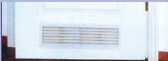
Drzwi do łazienki obowiązkowo powinny posiadać kratkę nawiewną a nie atrapę, jak to często się zdarza.
