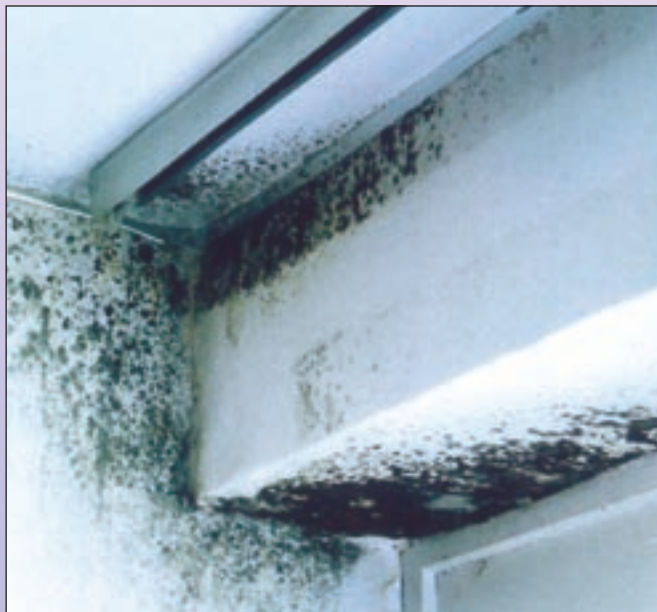
Grzyby zagrażają nie tylko zdrowiu, bo wydzielanymi przez siebie kwasami organicznymi potrafią zniszczyć cegłę, beton, tynki.
