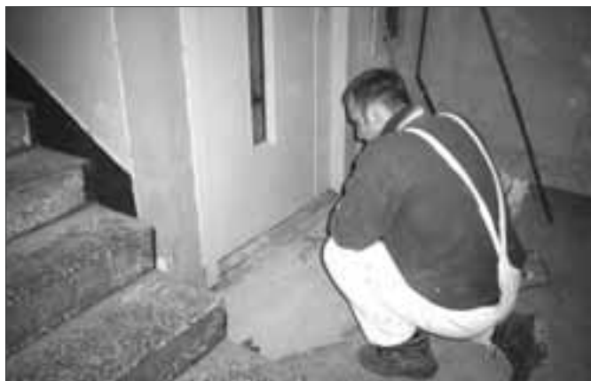
Os. „Tuwima – trwają prace odnawiające klatki schodowe w budynkach ul. Wojciecha Korfanteo 1 i 3.
