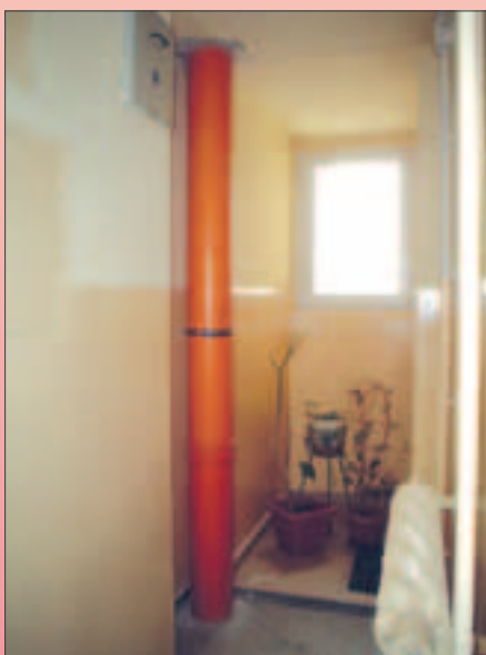
Os. „Tuwima” – wymiana instalacji deszczowej ul. Okrężna 1 – na dachu, pionu w klatce schodowej, w piwnicy.
