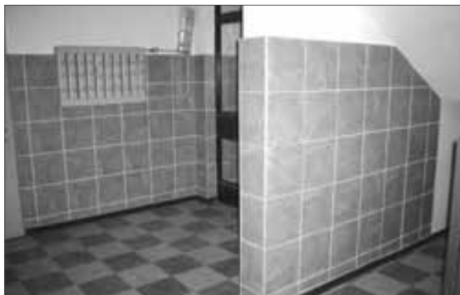
Os. „Tuwima – zakończono malowanie klatek schodowych wraz z położeniem kafelek na parterach ul. Hermana Wróbla 1A, B.
