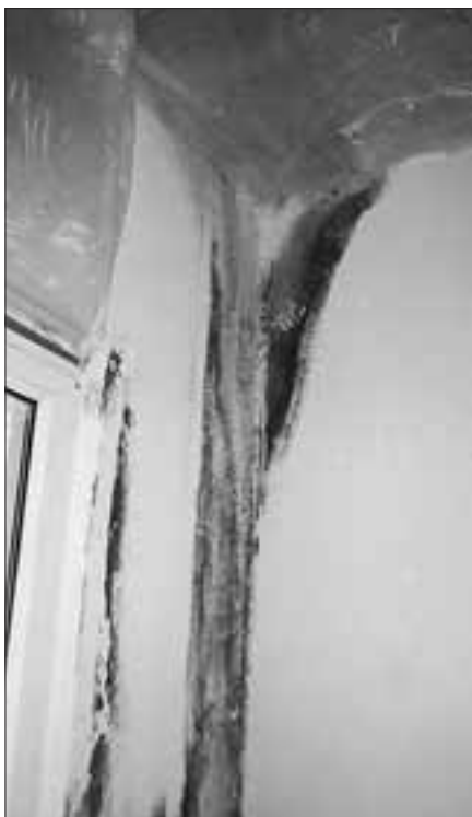
Grzyby zagrażają nie tylko zdrowiu, bo wydzielanymi przez siebie kwasami organicznymi potrafią zniszczyć cegłę, beton, tynki.
