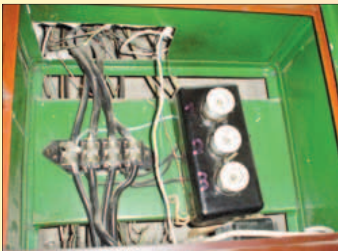
Stare i nowe zabezpieczenia przedlicznikowe.
