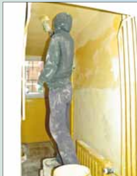
os. „Centrum”. W styczniu odnawiano między innymi parter budynku przy Powstańców 54C
