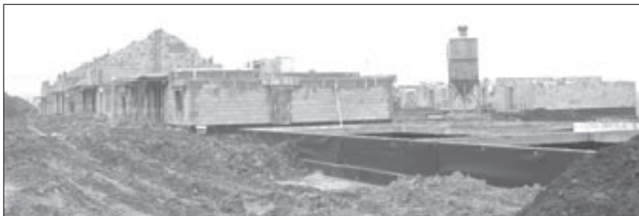
Zima nie przerwała prac przy budowie domków na os. „Węzłowiec”
