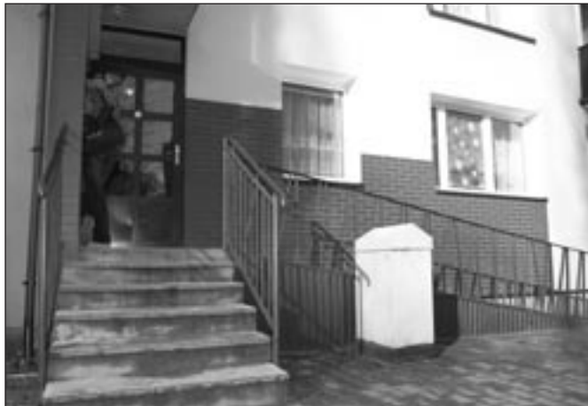
Nowe solidne drzwi do piwnicy i zwiększona czujność mieszkańców, to efekt pożaru w skutek którego z dymem poszło 20 tysięcy zł z funduszu wyłącznie tej nieruchomości.
