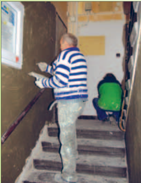
Roboty przy Komuny Paryskiej 13
