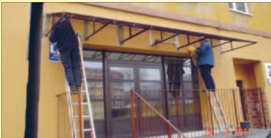
Montaż daszków z poliwęglanu nad rampami lokali użytkowych przy ul. Walerego Wróblewskiego 26A, B, C i 28A
