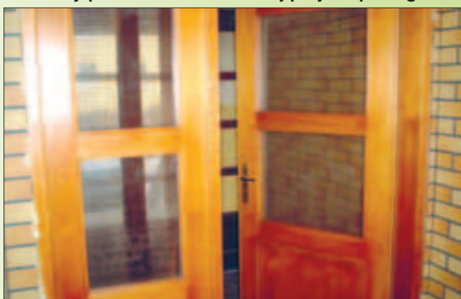
ul. Grunwaldzka 6A, B, C – remont parterów m.in. zabudowano nowe - drugie - drewniane drzwi.
