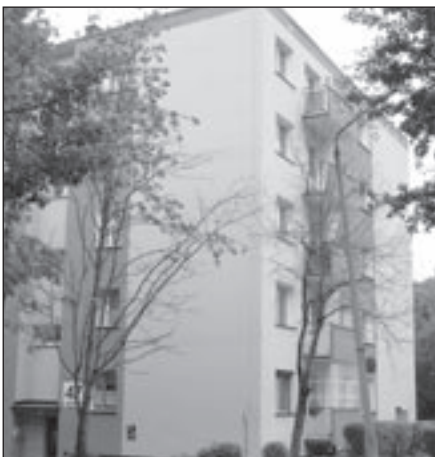
Kolejne tysiące m 2 elewacji ocieplono w ub.r.
