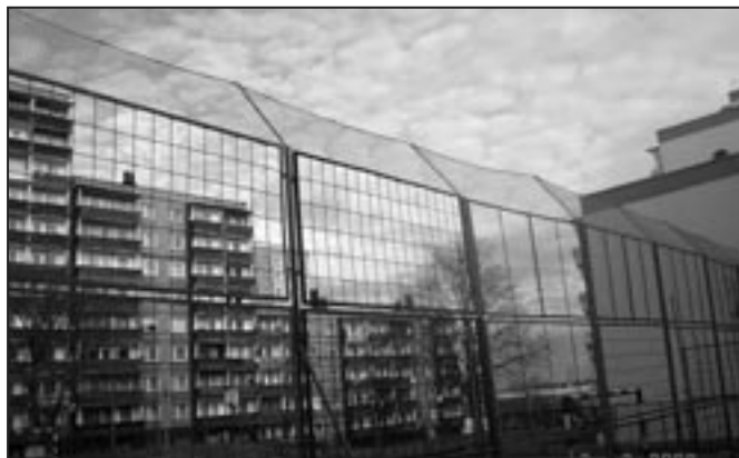
Poprawiono zabezpieczenie boiska: podwyższono piłkołapy.
