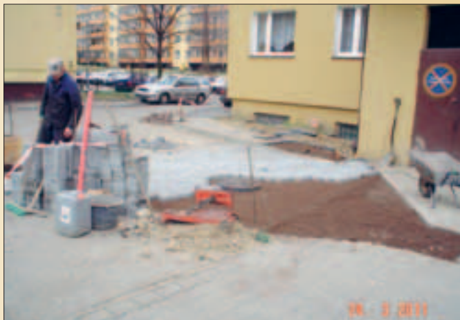
Os. „Węzłowiec” – Władysława Jagiełły 1C, styczniowa wymiana przyłącza kanalizacji i przywracanie terenu do stanu poprzedniego.
