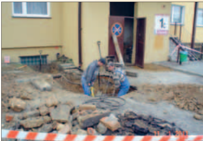
Os. „Węzłowiec” – Władysława Jagiełły 1C, styczniowa wymiana przyłącza kanalizacji i przywracanie terenu do stanu poprzedniego.
