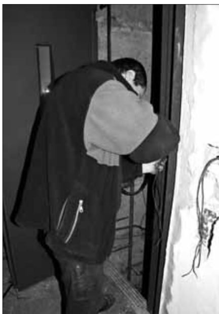
os. „Młodych” – Montowanie kasety wezwań windy przy ulicy ZHP 9. To jedna z robót towarzyszących.
