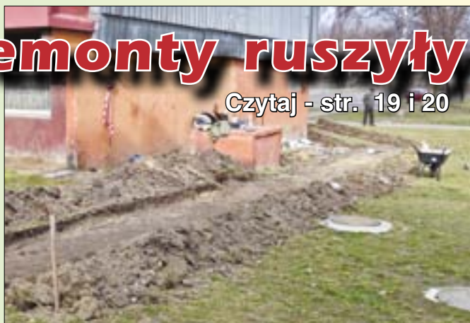
Osiedle „Tuwima”. Utwardzenie terenu od Hermana Wróbla 7A w kierunku Wróbla 15-21, to nowy chodnik
