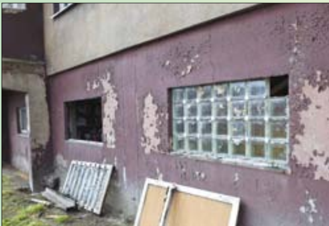
Osiedle „Tuwima”. W budynkach przy ul. Hermana Wróbla 7 i 8 okna piwniczne zabudowano luksferami
