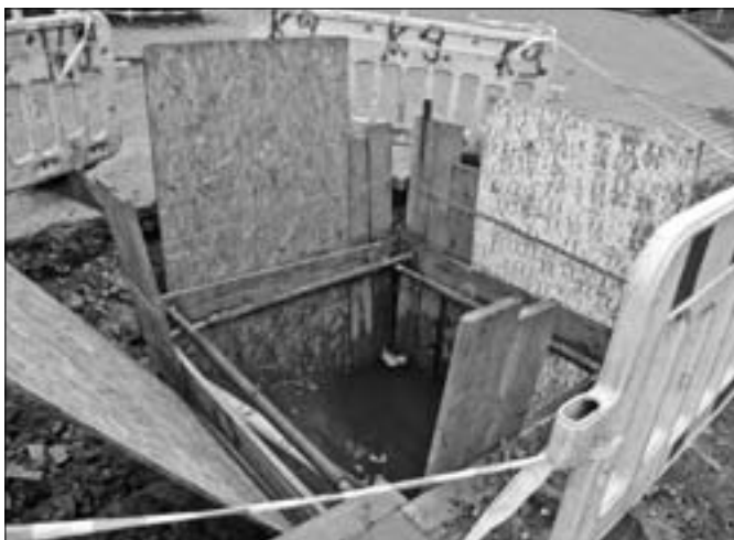
Osiedle „Chemik”. W rejonie budynku przy W. Wróblewskiego 49 wymieniany jest gazociąg niskiego ciśnienia
