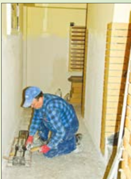
Osiedle „Młodych”. Na parterze budynku przy ulicy ZHP 10 układane są płytki klinkierowe
