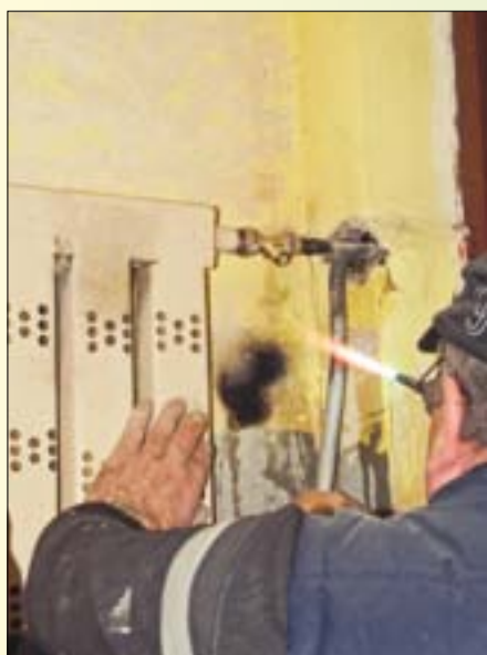
Osiedle „Tuwima”. Hermana Wróbla 2 - kapitalny remont wszystkich klatek
