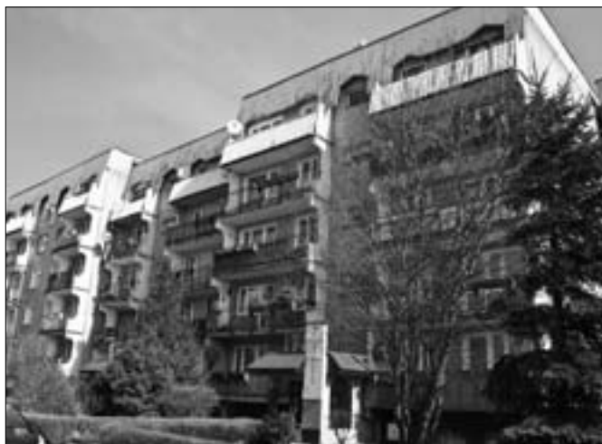
Osiedle „Bańgów”. W tym roku kolejne budynki będą docieplone a balkony wyremontowane – ulica K. Szymanowskiego 1-9
