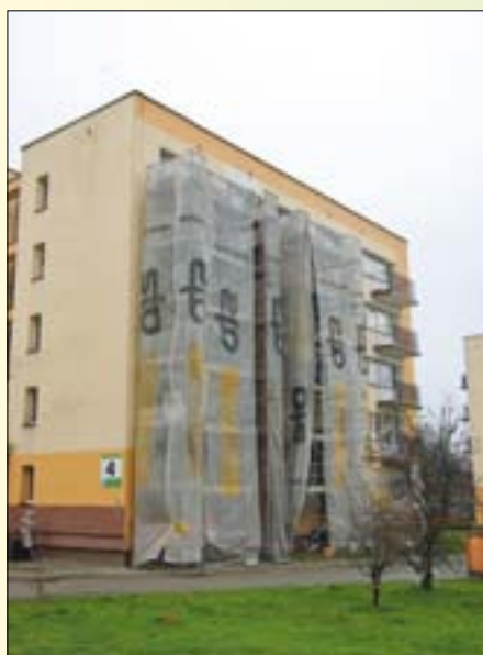
Osiedle „Centrum”. Rusztowanie stoi, remontują balkony – Ryszarda Gansińca 4
