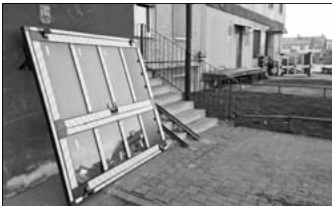
Osiedle „Węzłowiec”. Tu jeszcze „zapakowane”, ale już są zabudowane wszystkie II drzwi w domu przy Wł. Jagiełły 37A, B, C, D
