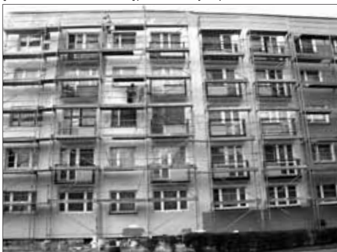
„Michałkowice”, docieplono dom i wyremontowano balkony przy ul. Przyjaźni 42.
