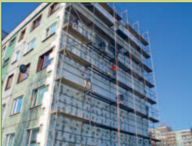
Przy Władysława Jagiełły 27A, B kontynuowane są prace dociepleniowe.
