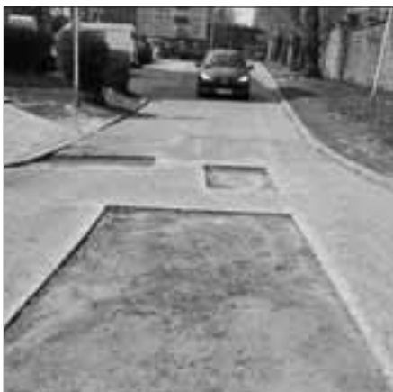
Pod koniec kwietnia przy ulicy Powstańców 46-54 wszystko było gotowe do naprawienia uszkodzonej drogi.
