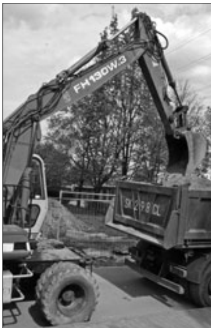
Os. „Tuwima” - roboty ziemne komplikują nieco dojazd do garaży przy Okrężnej (na zdjęciu garaże widoczne w tle)
