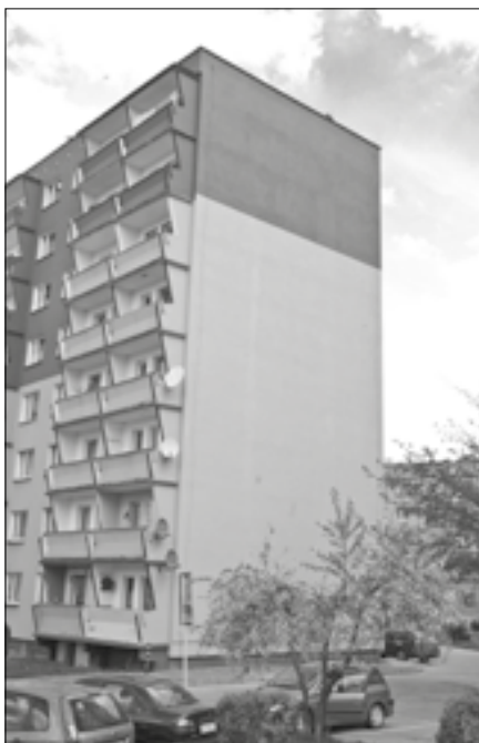
Os. „Węzłowiec” - w zeszłym roku poza planem wykonano elewację budynku przy Wł. Jagiełły 1C
