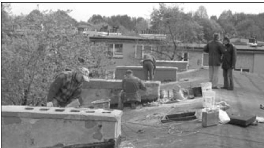
Każdy komin, a jest ich łącznie 60, został poddany remontowi.
