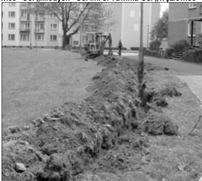
200 metrów kabla plus nowe oprawy i... będzie jasno.
