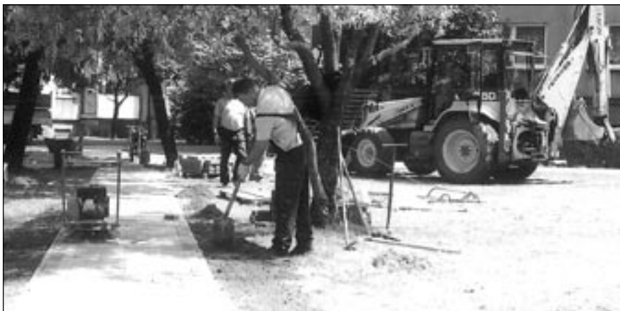
Powstaje nowy chodnik – ul. Przyjaźni 24-26.
