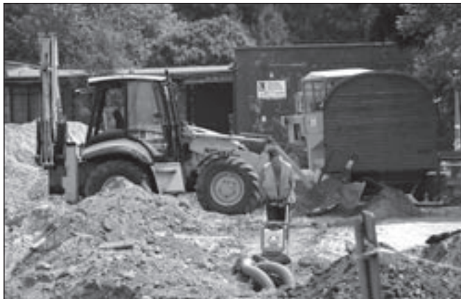
Nim położą się nawierzchnię – pod ziemią trzeba zrobić porządek i uporać się z wszelkimi instalacjami.
