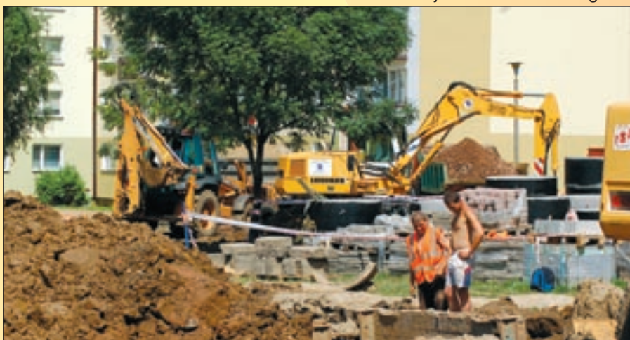
Bardzo głębokie wykopy stały się codziennością w Michałkowicach.
