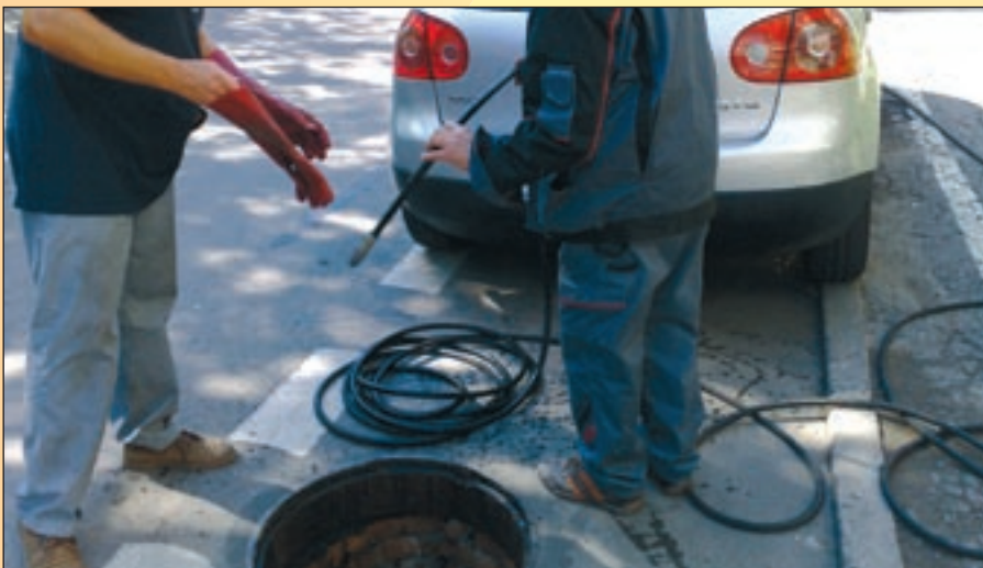
Czyszczenie przykanalików – ul. Wojciecha Korfatego 9 .
