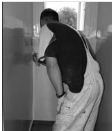
Ostatnie poprawki i klatka schodowa będzie gotowa – ul. Okrężna 13.
