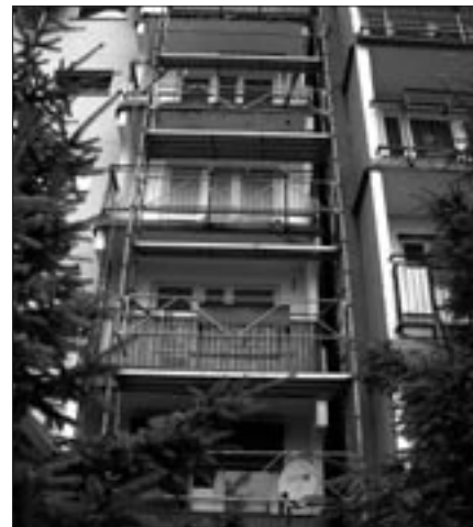
Remont balkonów przy ul. Marii Skłodowskiej-Curie 21.
