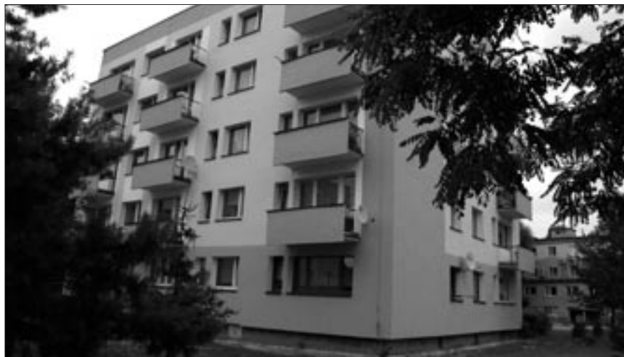
ul. Ryszarda Ganszińca 10 – Docieplona ściana wschodnia i południowa budynku.
