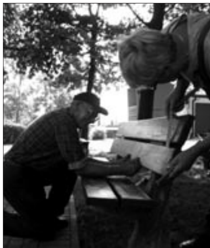
Zrobienie nowej ławki także wymaga precyzji – ul. Walerego Wróblewskiego 71-73.
