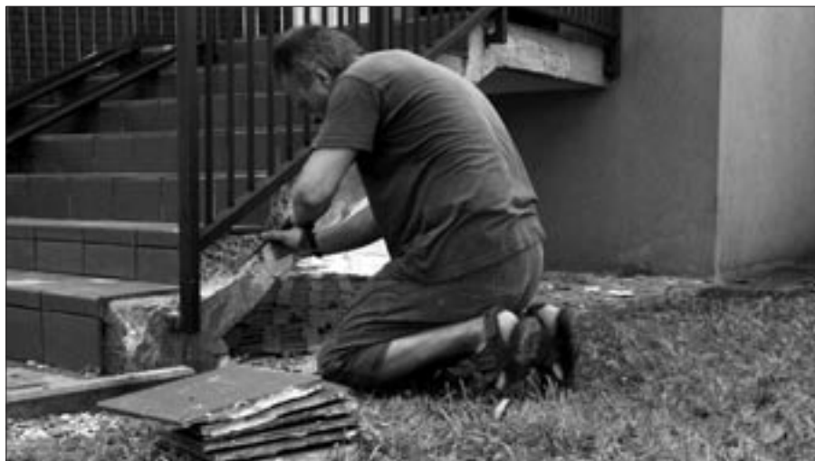
Prace konserwatorskie na schodach do budynku przy Grunwaldzkiej 16C.
