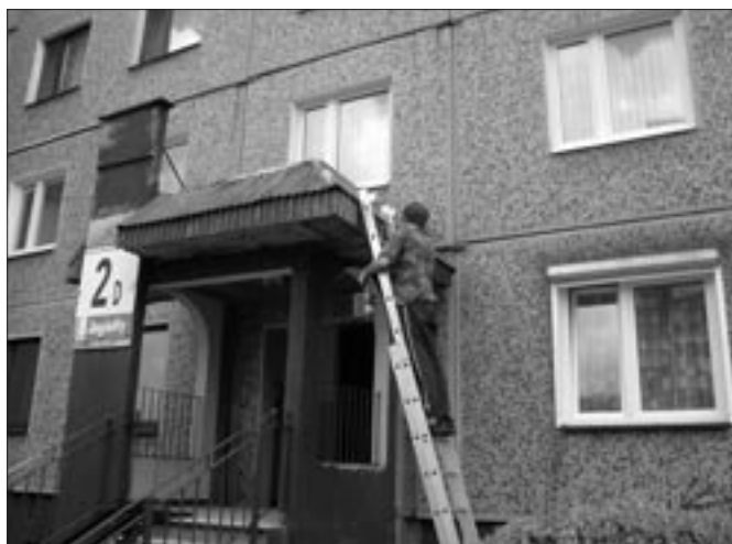
Odnawianie daszków nad wejściami do budynku Władysława Jagiełły 2A, B, C, D.
