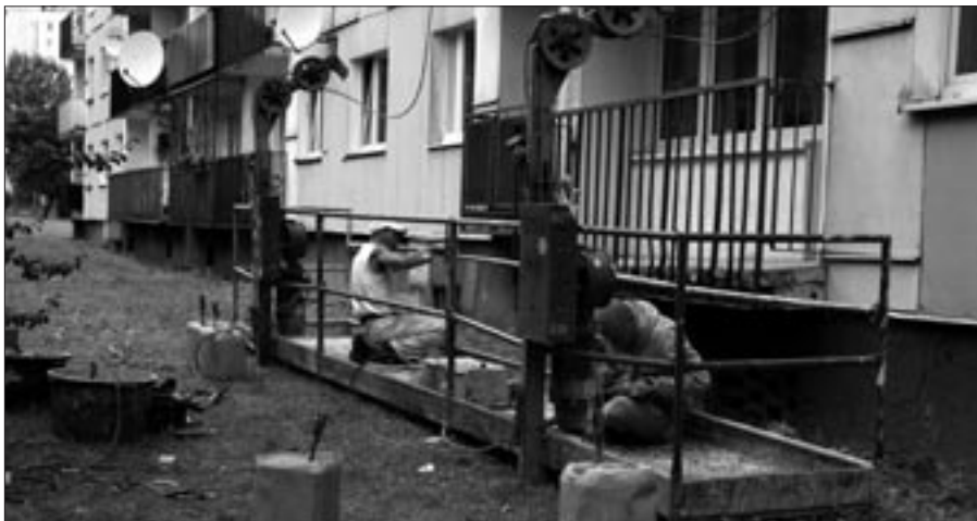
ul. Szarych Szeregów 1-4 – ostatnie przygotowania do rozpoczęcia prac.
