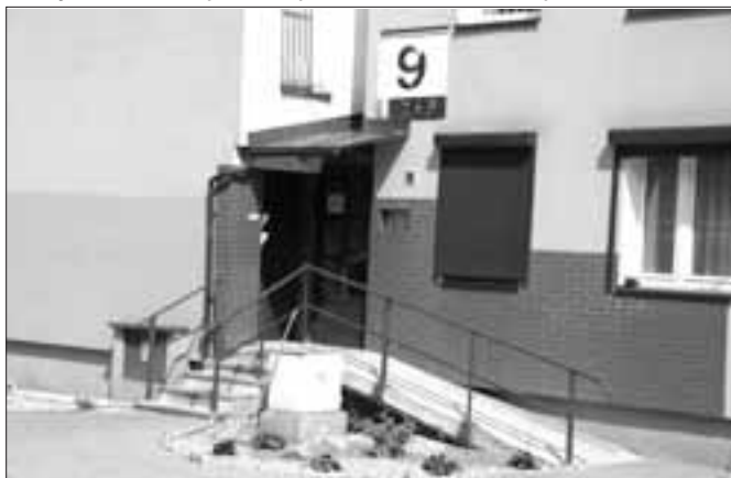
W budynkach przy ul. ZHP 9 i Wojciecha Korfanteo 1C trzykrotnie, w kilku innych po dwa razy w ostatnim czasie krzywki „znikały” i unieruchamiały dźwigi.
