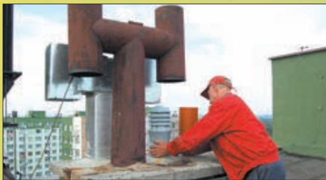
Na dachu przewody zwieńczą: z lewej stara i nowa nasada typu „H” na kanałach spalinowych, w środku nowa nasada wzmacniająca siłę ciągu wentylacji wywiewnej.
