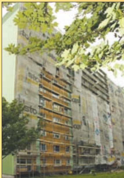
Docieplanie budynku przy Szarych Szeregów.
