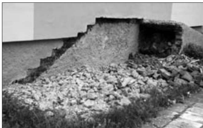
Znikają wreszcie nieużywane podjazdy i schody przy ul. Walerego Wróblewskiego.
