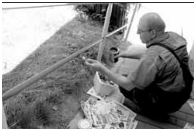
„Chemik” – malowanie balustrady przy schodach zewnętrznych ul. W. Wróblewskiego 71.
