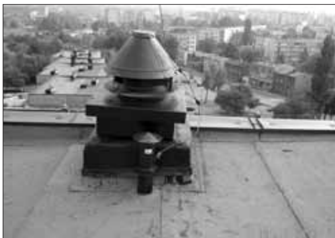
Osiedle „Węzłowiec” – Władysława Jagiełły 1C – kolejny gruntownie wyremontowany dach.
