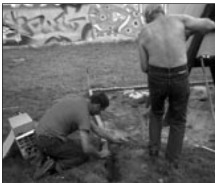
Powstaje strefa bezpiecznego upadku.
