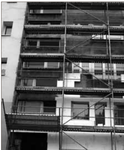
Rusztowania na budynku przy ul. Walerego Wróblewskiego 51-53, czyli czas docieplenia.
