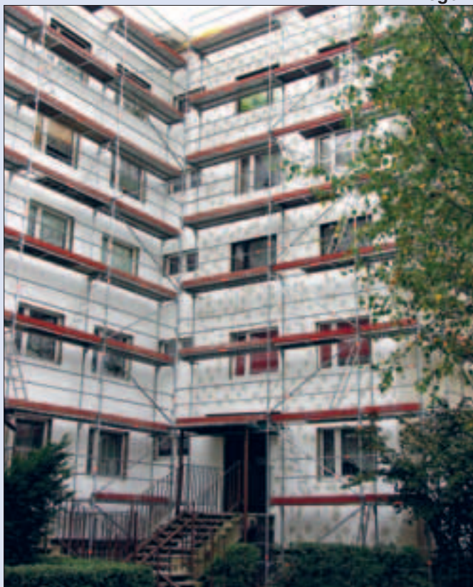
Rusztowania przy Przyjaźni 26, gdzie trwa docieplenie budynku.
