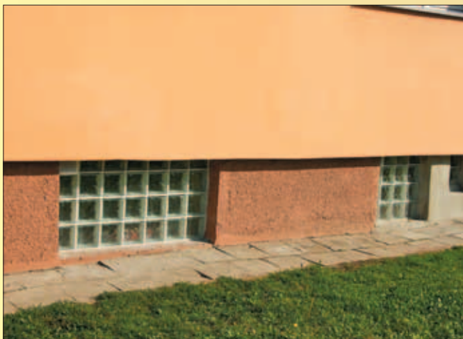
os. „Centrum” – ulica Ryszarda Gansińca 9 – w miejscu okienek piwnicznych pojawiły się luksfery. Zakłada się je również na innych osiedlach.
