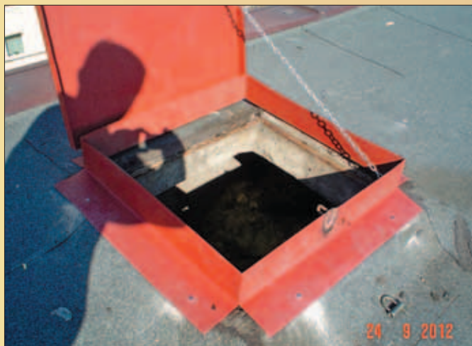
os. „Węzłowiec” – Władysława Jagiełły 3A nowa kłapa włazowa na dach poprawi komfort zamieszkania.
