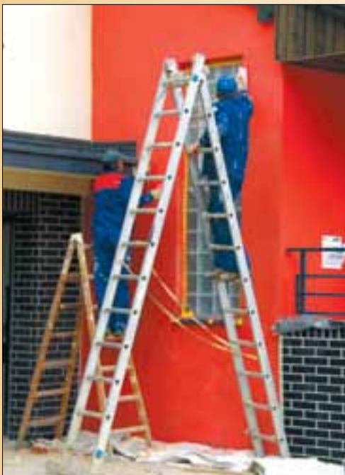
Os. „Tuwima” – Prace malarskie na nowym budynku – H. Wróbla 17.
