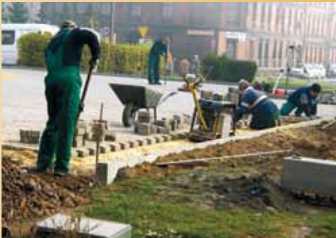
Os. „Centrum” – Prace przy nowym parkingu – Powstańców 54.
