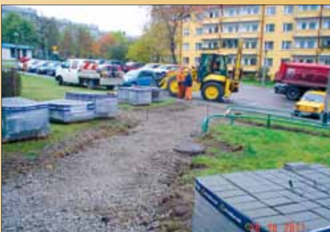
Os. „Węzłowiec” – Walerego Wróblewskiego 30B i 32 kapitalny remont chodnika.
