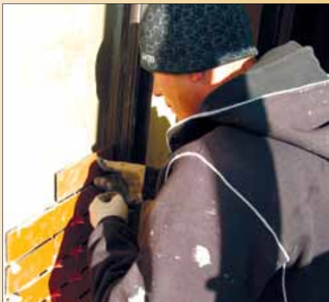
Os „Centrum” – Kładzenie płytek klinkierowych na wejściu do klatki schodowej – Komuny Paryskiej 3.
