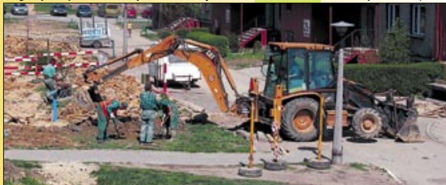
Osiedle to także ogromna podziemna infrastruktura. Wymiana sieci wodociągowej na os. „Węzłowiec”
