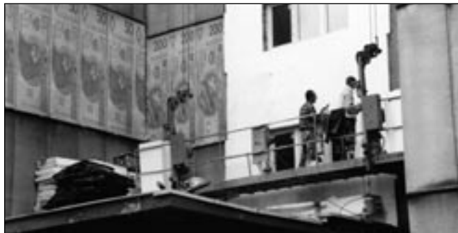
28 milionów 520 tysięcy złotych pochłonie całość prac termomodernizacyjnych budynków SSM.
