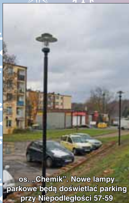
os. „Młodych”. Trwają prace na balkonach budynku przy W. Wróblewskiego 6
