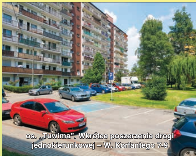
os. „Węzłowiec”. Trwa remont chodników – Wł. Jagiełły 11
